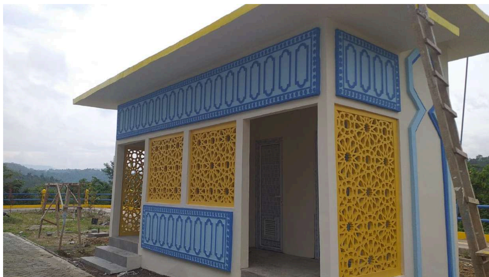
PEMASANGAN GRC TOILET BENDUNGAN RUKOH
