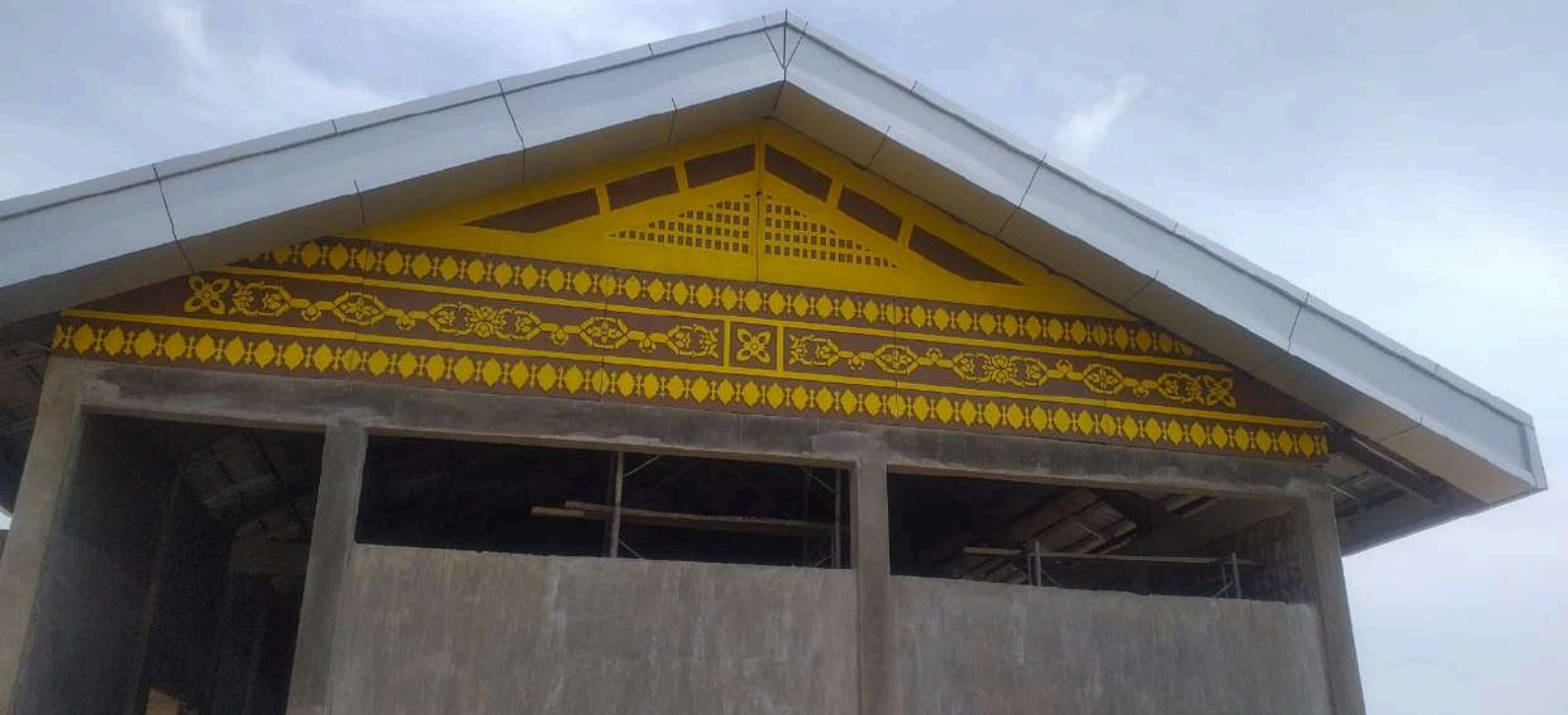
PEMASANGAN GRC GUDANG CORE BOX BENDUNGAN RUKOH
